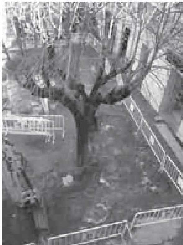
Imatge de la plaça de la Font durant el procés de les obres.
