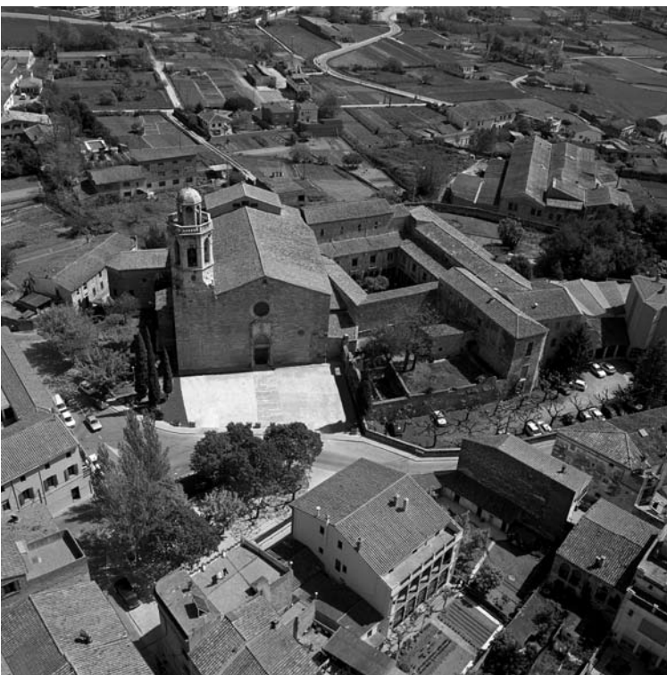
Al costat de la façana del monestir de Sant Esteve, antigament hi havia hagut una torre de defensa de l'abadia. (AMB).
