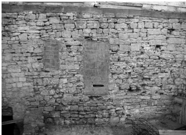
La muralla del raval de Sant Pere durant les obres de reforma de Ca l'Hereu. Autor: Esteve Palmada.
